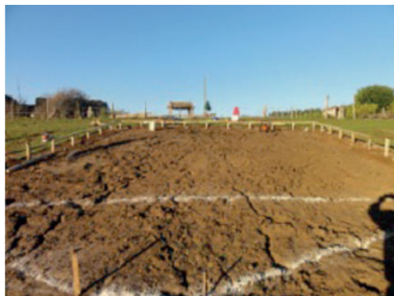
Figura 37. Estructura de soporte en polines impregnados enterrados.
