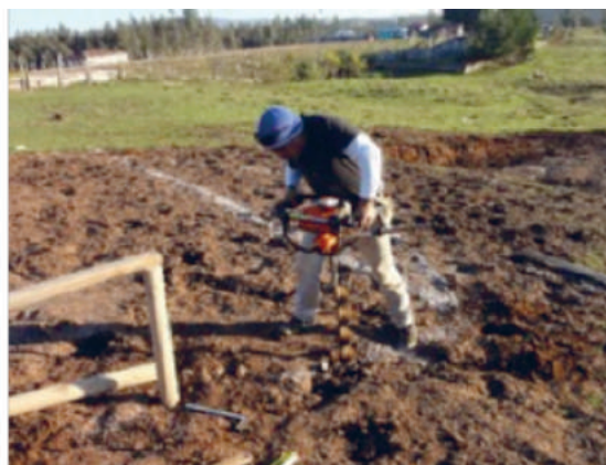
Figura 36. Trabajo de perforaciones con el barreno.
