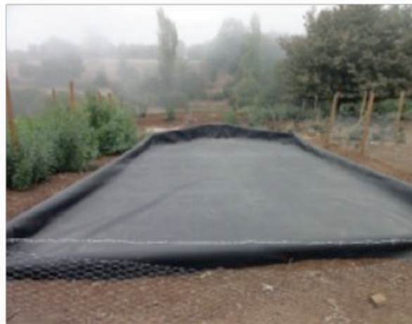
Figura 44. Área de captación terminada.
