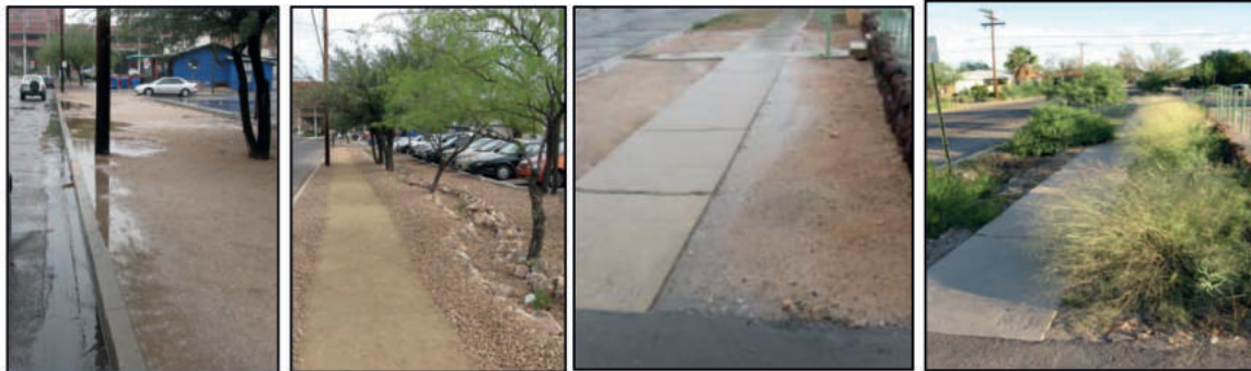
Figura 100. Vista antes y después de la aplicación de la metodología de infraestructura verde junto a rutas peatonales impermeables, donde el agua de las tormentas no logra llegar a la calle, sino más bien se queda en el lugar de origen. Imágenes cortesía de Brad Lancaster ( www.HarvestingRainwater.com ).
