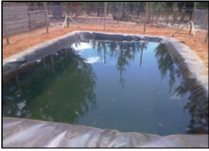
Figura 110: área de acumulación en Geomembrana de 1 mm de espesor.
