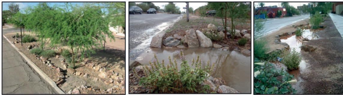
Figura 99. La infraestructura verde involucra la construcción de depresiones en la zona comprendida entre la calle y la propiedad privada, con el fin de dirigir el agua de lluvia que fluye por las calles. Imágenes cortesía de Watershed Management Group ( www.watershedmg.org ).
