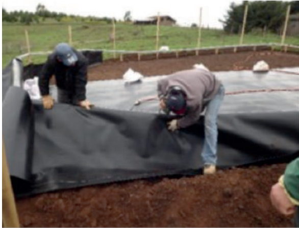
Figura 41. Instalación de la geomembrana en la estructura de soporte del área de captación.
