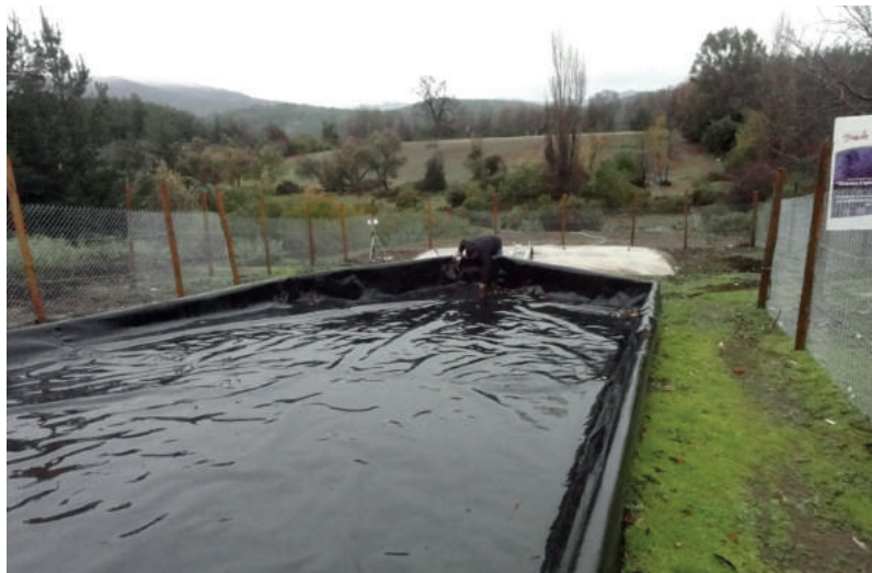
Figura 1. Cisterna abierta para la recolección de agua lluvia. Yemen. Fuente: Laureano (2002).
