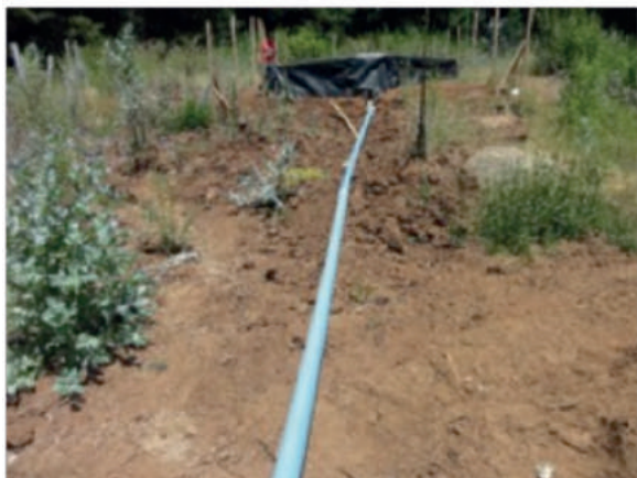
Figura 69. Instalación del sistema de conducción.
