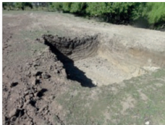
Figura 64. Movimiento de tierra y excavación de la zona de acumulación.
