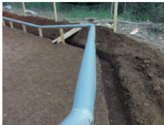
Figura 38. Coronación de los listones con PVC y Zanja.
