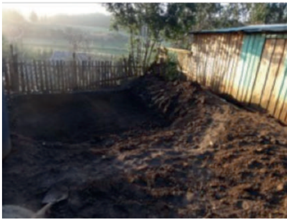
Figura 61. Excavación área de acumulación.
