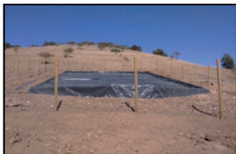
Figura 102: área de Captación en ladera. Sector González Bastías, comuna de San Javier.
