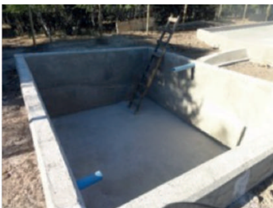
Figura 68. Hormigonado del área de acumulación.
