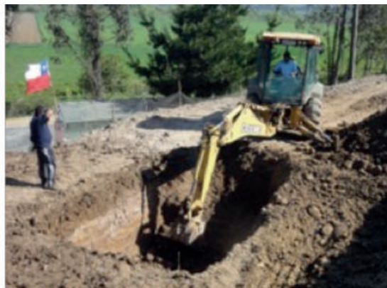
Figura 46. Trabajos de maquinaria para el movimiento de tierra.
