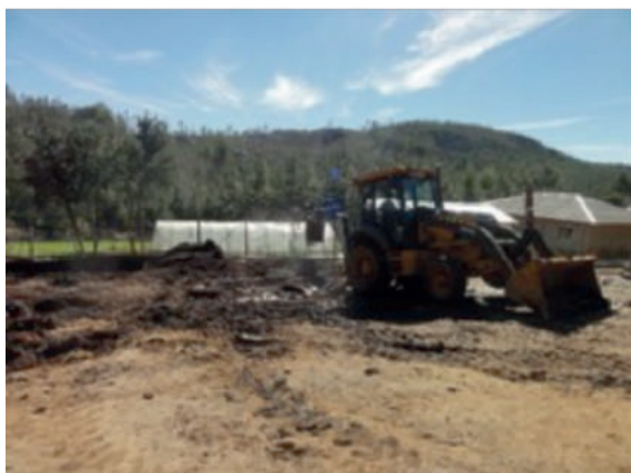
Figura 33. Movimiento de tierra con retroexcavadora.
