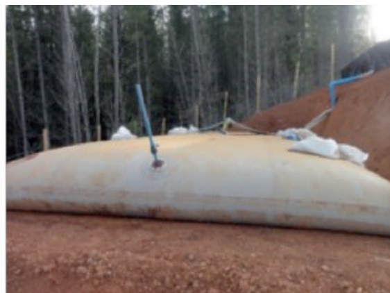
Figura 56. Hidroacumulador con agua.
