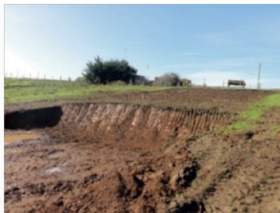
Figura 34. Movimiento de tierra con retro y pala.
