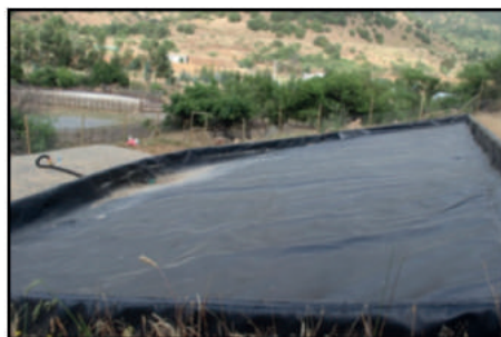
Figura 103: área de Captación en ladera. Sector Huilliborgoa, comuna de San Rafael.
