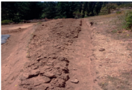
Figura 113: obra de mitigación en la parte alta del Talud. Retiro del material y compactado.
