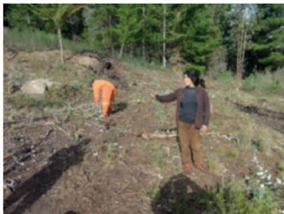
Figura 57. Limpieza del terreno.
