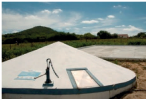
Figura 26: Programa P1+2 , Cisternas de acumulación de aguas lluvias y áreas de captación.
