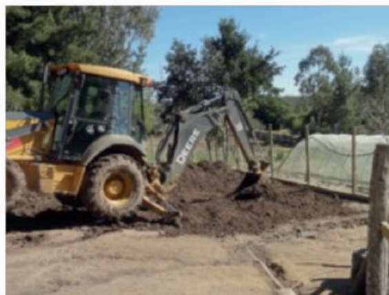
Figura 52. Movimiento de tierra con retroexcavadora.
