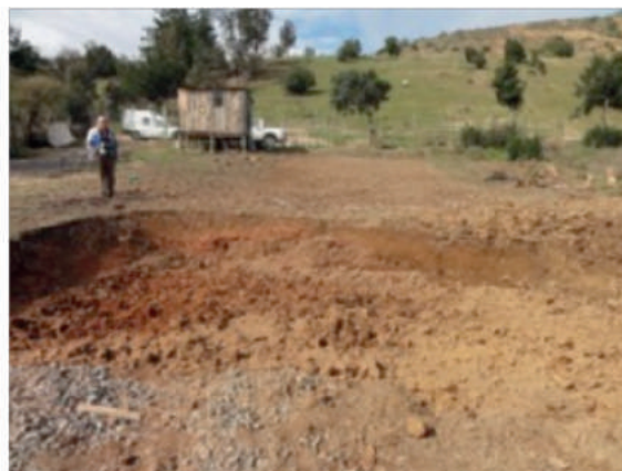
Figura 32. Limpieza y escarpado.
