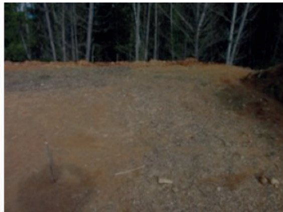
Figura 50. Limpieza del sitio demostrativo.
