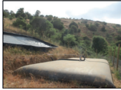
Figura 111: área de acumulación en base a un tanque flexible. Sector Huilliborgoa San Rafael
