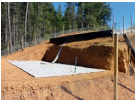
Figura 55. Instalación del hidroacumulador de PVC.
