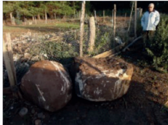
Figura 60. Presencia de grandes rocas extraídas con la retroexcavadora.
