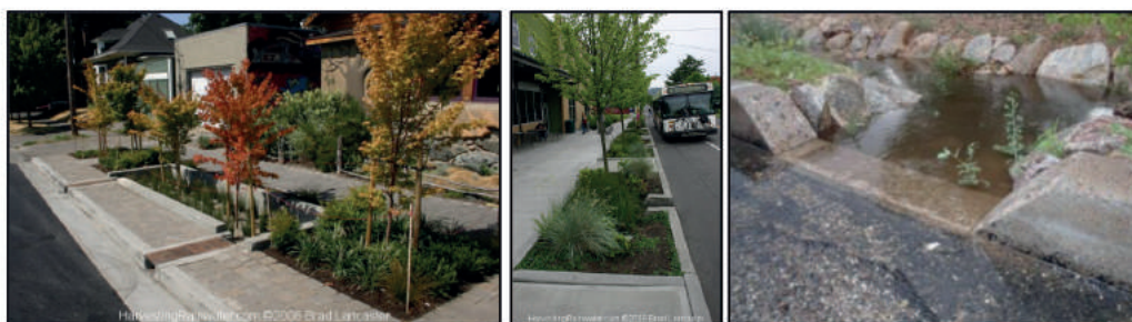
Figura 98. La escorrentía que fluye por las calles durante las tormentas, se desvía hacia las zonas de acumulación mediante el corte de la berma. Imágenes cortesía de Brad Lancaster ( www.HarvestingRainwater.com ) y Watershed Management Group ( www.watershedmg.org ).
