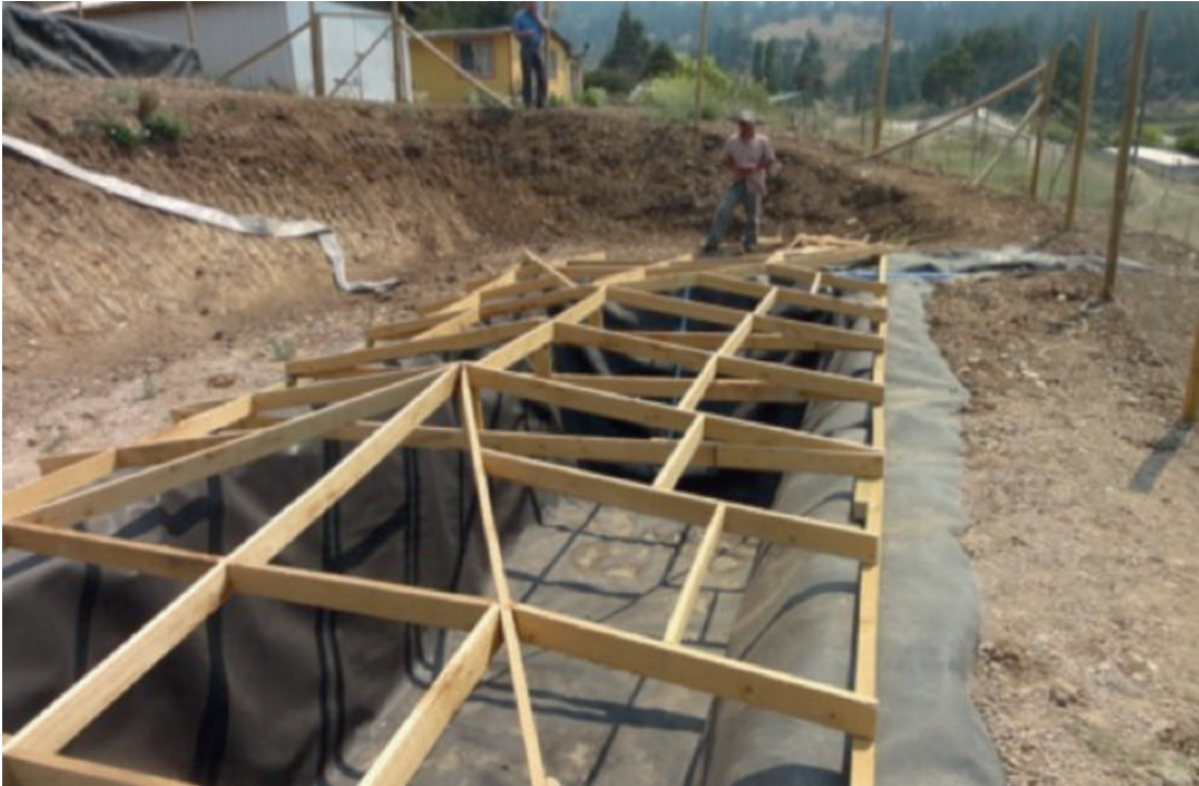
Figura 82: cisterna de acumulación generada por una excavación revestida con geomembrana
