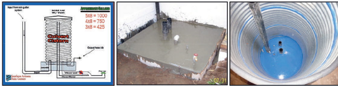
Figura 96. Sistema de plomería de una cisterna galvanizada, el cual involucra un tubo de entrada, un tubo de rebalse, un tubo de limpieza y un grifo de salida. Una vez instalada la cisterna y secado el concreto, se finaliza el trabajo con la aplicación de un sellante no tóxico. Fuente: Southern Arizona Rain Gutters ( www.southernarizonaraingutters.com ).
