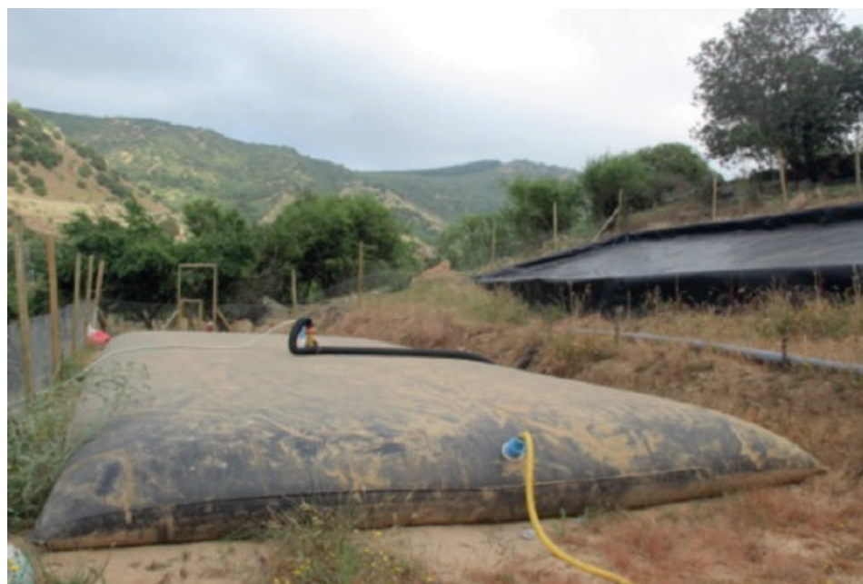
Figura 89: sistema de captación de aguas lluvias instalado por INDAP en el sector Huilliborgoa, San Rafael
