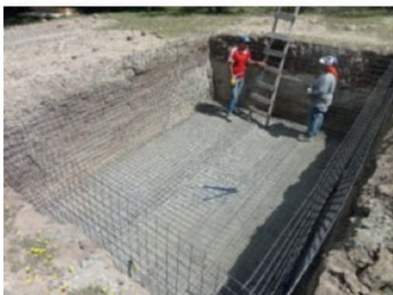
Figura 65. Enfierradura con malla Acma C- 139.
