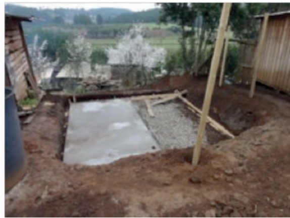
Figura 62. Radier en donde se emplazará el estanque de polietileno.
