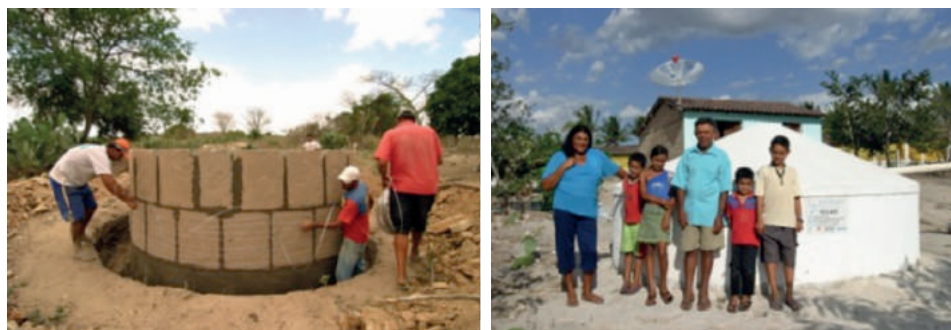
Figura 22: construcción de Cisterna, Hormigón prefabricado.
