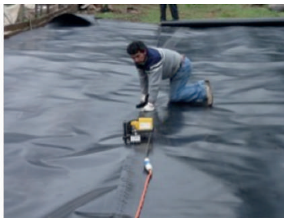
Figura 40. Fusionado de la Geomembrana.
