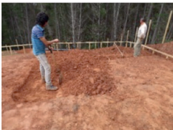
Figura 53. Excavación con herramientas de mano.
