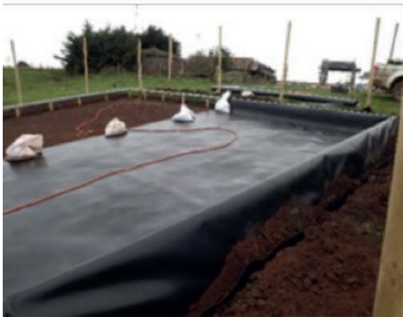
Figura 43. Zanja perimetral en donde va enterrada la geomembrana.
