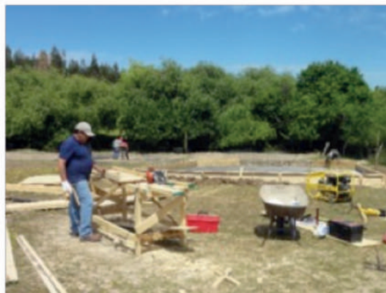
Figura 66. Trabajos de carpintería de moldaje para recibir el hormigón.
