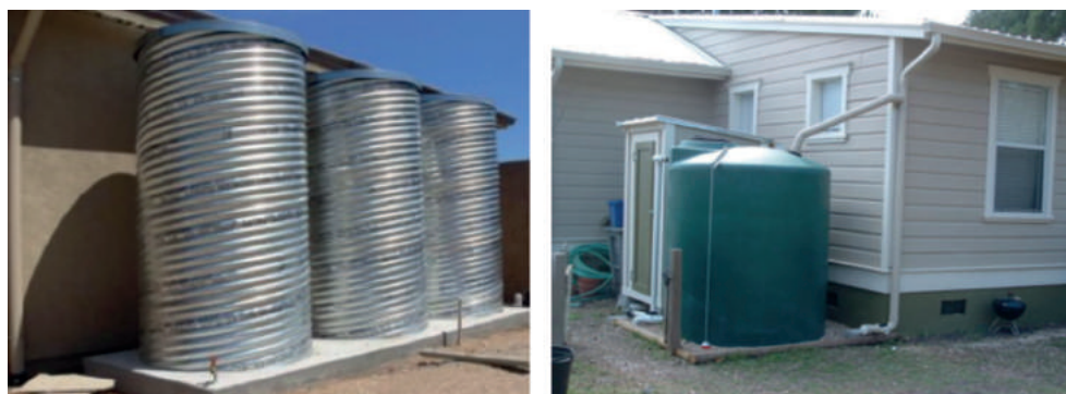
Figura 95. Los tanques más utilizados para la elaboración de SCALLs urbanos en Estados Unidos son de metal corrugado en ambientes áridos (izquierda) y plástico duradero en climas más húmedos (derecha). Fuente: southernarizonaraingutters.com y www.watercache.com.
