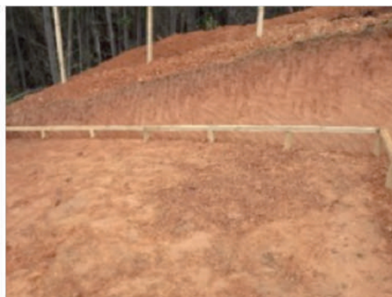
Figura 54. Área donde se emplazará el hidroacumulador de PVC.
