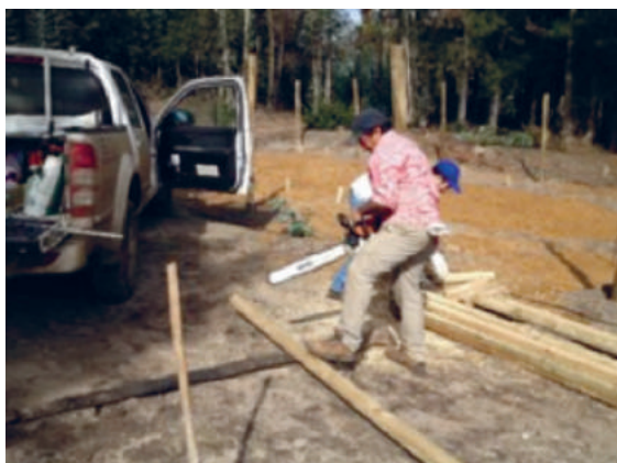
Figura 35. Trabajo de carpintería corte de los polines.
