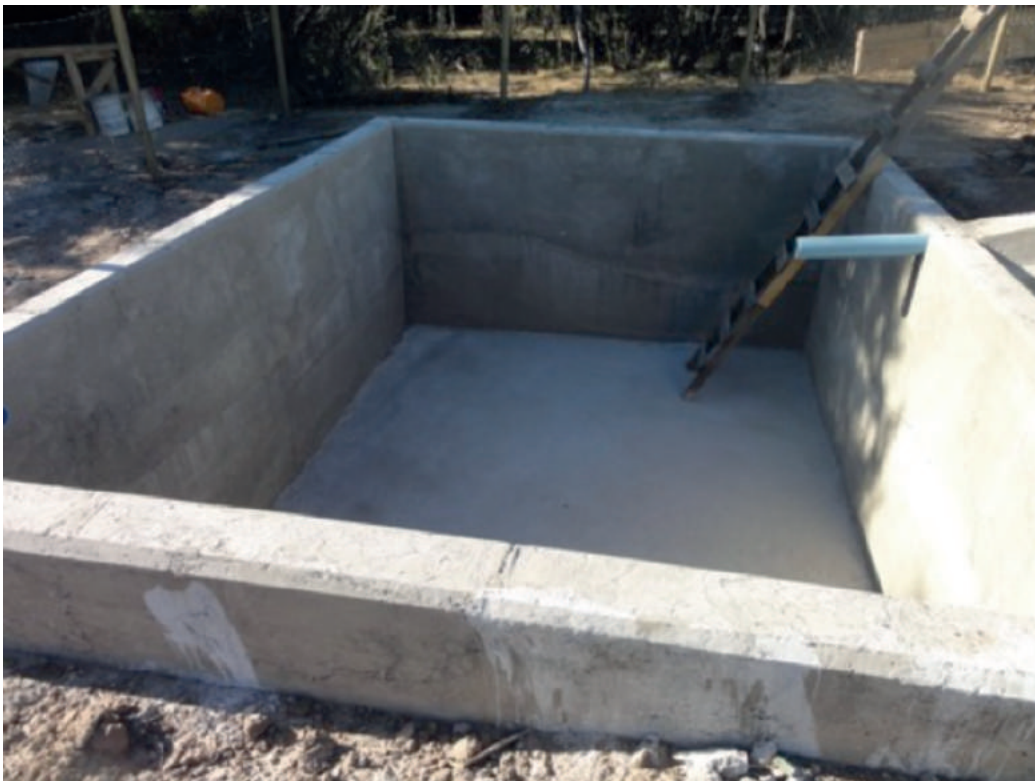
Figura 83: cisterna de acumulación de hormigón
