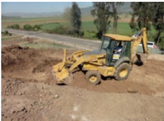
Figura 45. Trabajos de maquinaria en el movimiento de tierra y excavación del área de acumulación.
