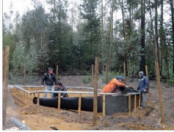
Figura 42. Sellado y soldado de la geomembrana.
