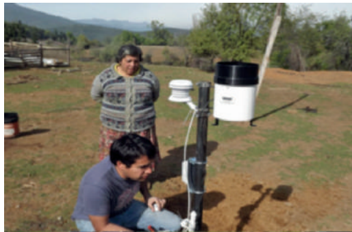
Figura 5: instalación Mini-estación sector Loma de Vásquez, Longaví.
