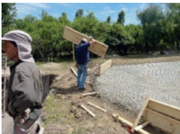
Figura 67. Instalación de moldajes.
