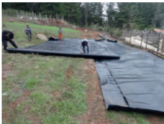
Figura 39. Corte de la geomembrana para su fusionado.
