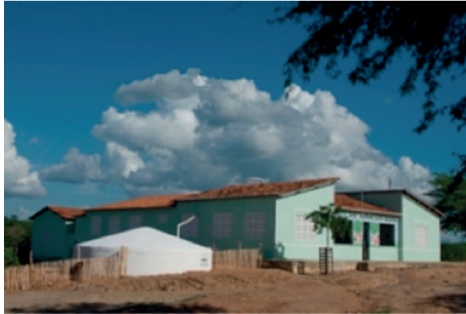
Figura 25: Programa PIMC , Cisternas de acumulación de aguas lluvias en Escuelas.
